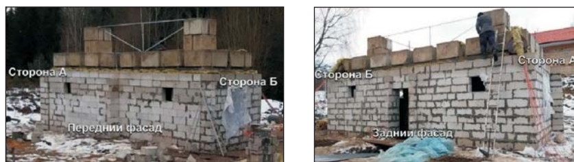
Рис. 2. Общий вид испытательного фрагмента каркасного здания
