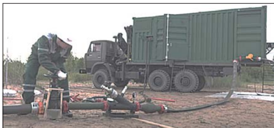
Рис. 6. Приспособление – вставка в рукавной линии
