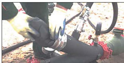
Рис. 4. Заправка пыжа в приспособление – вставку
