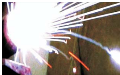
Короткое замыкание в коннекторе
